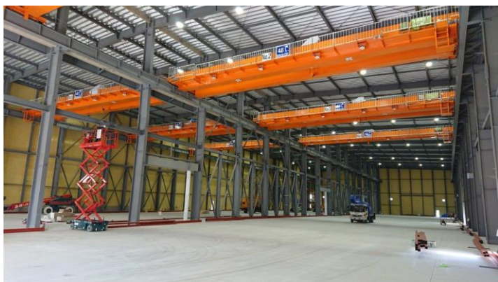
建設中 日野営業所 第二センター 5号倉庫
